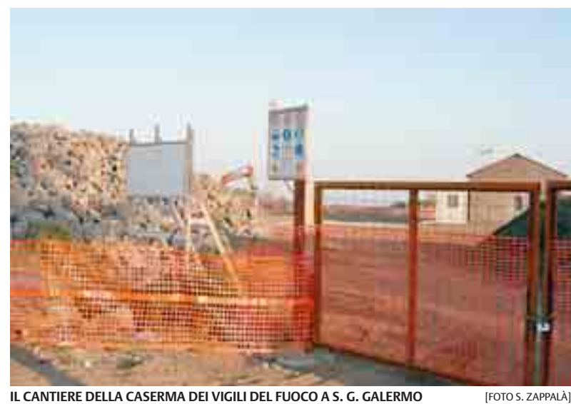
IL CANTIERE DELLA CASERMA DEI VIGILI DEL FUOCO A S. G. GALERMO
