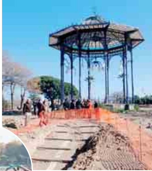
L'area del chiosco della musica e il grande piazzale ancora le due aree critiche in cui bisogna ancora lavorare
